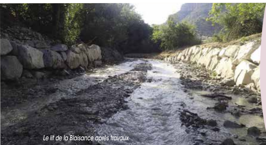
Le seuil aval, retiré pendant les travaux
