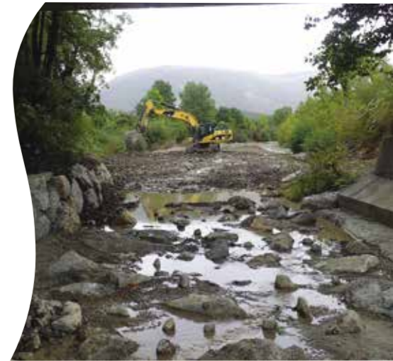
Radier et protection de la culée du pont en blocs d'enrochement bétonnés en rive droite de Maraize en fin de chantier
