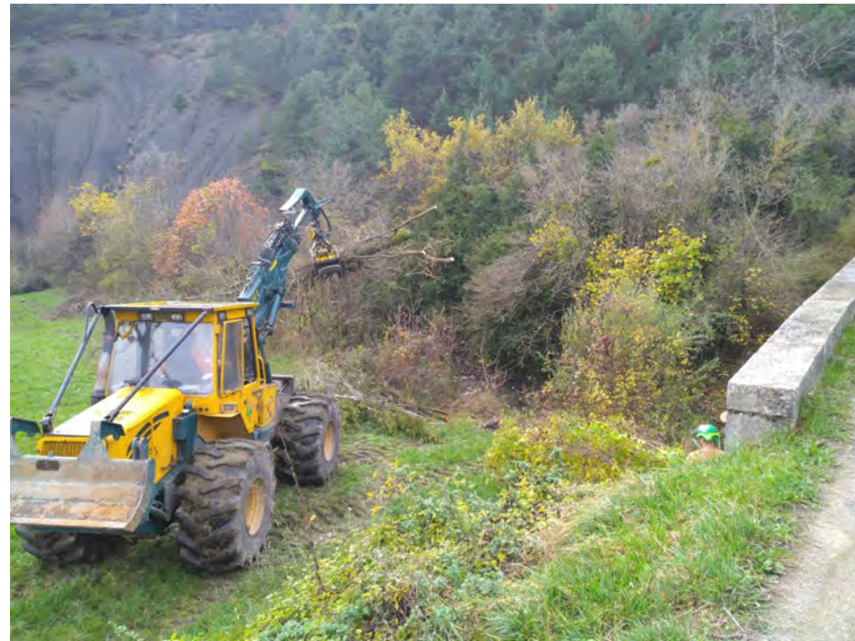
Extraction embâcle autour d'un pont, La Pierre, Aigue Vouluie
