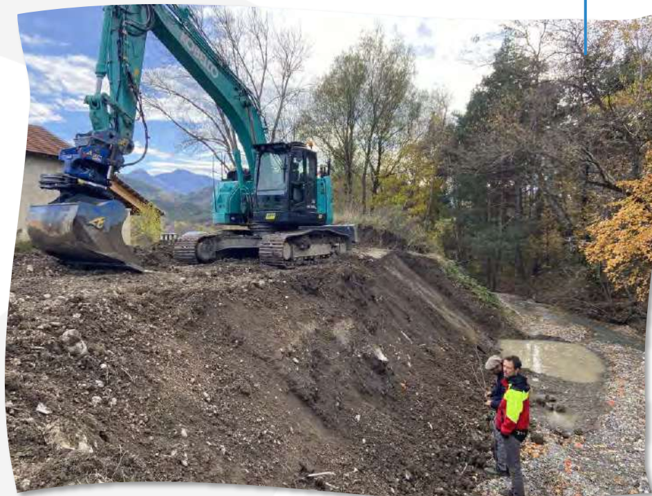
Chantier d'urgence : aux grands maux les grands remèdes
