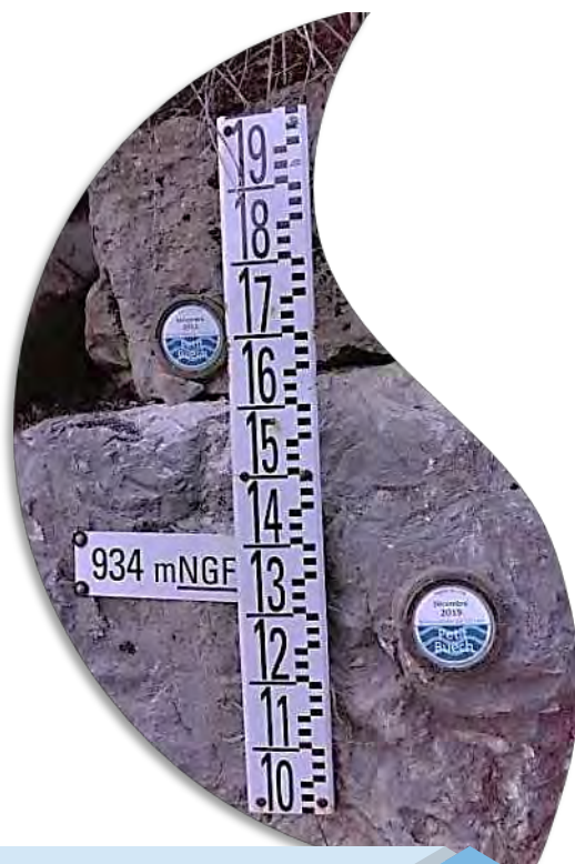
Échelle limnimétrique et repères de crues à La Roche des Arnauds
