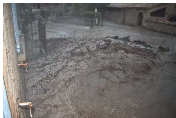
Obturation totale du pont de la RD1075 par la grêle et les débris – 04/09/2025
