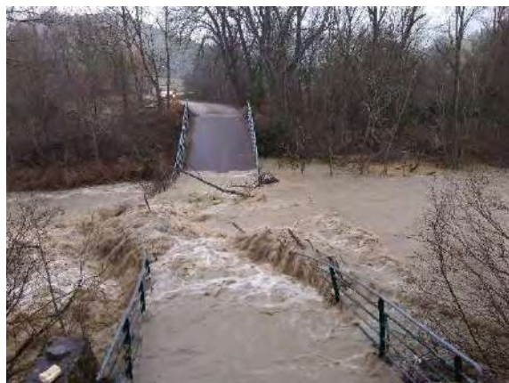
Pont des Iscles sur le torrent de Chauranne-Aspremont 20/12/2019
