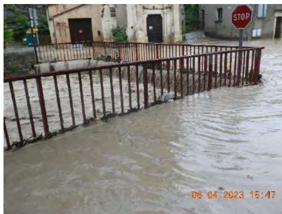
Pont sur la Méouge, Séderon – 04/06/2023
