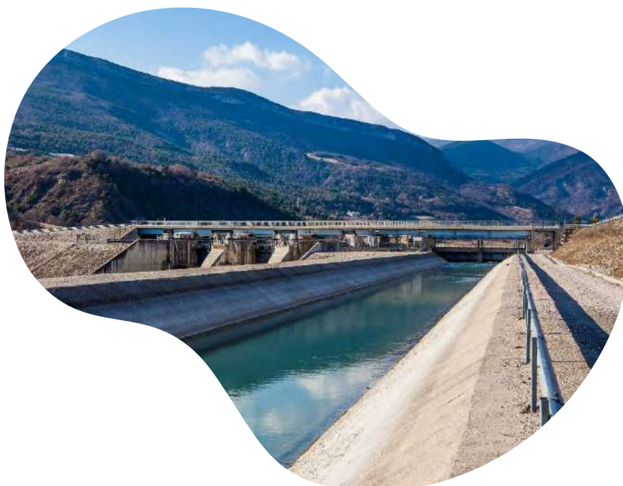
Le canal de fuite avec le barrage de Saint Sauveur en arrière-plan
