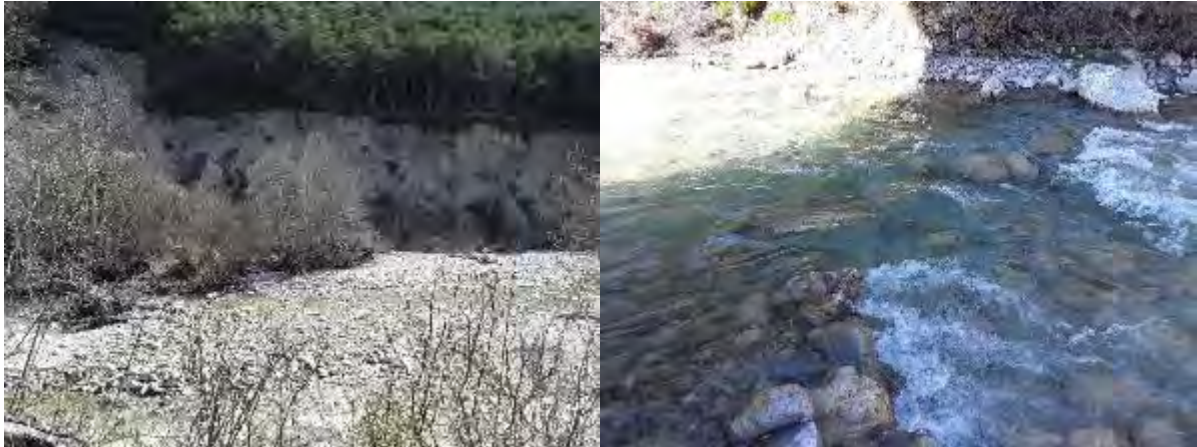
Figure 9 : Front d'érosion du versant du Bois des Faures et seuil en aval du pont de Seilles (AMETEN, 2023)
