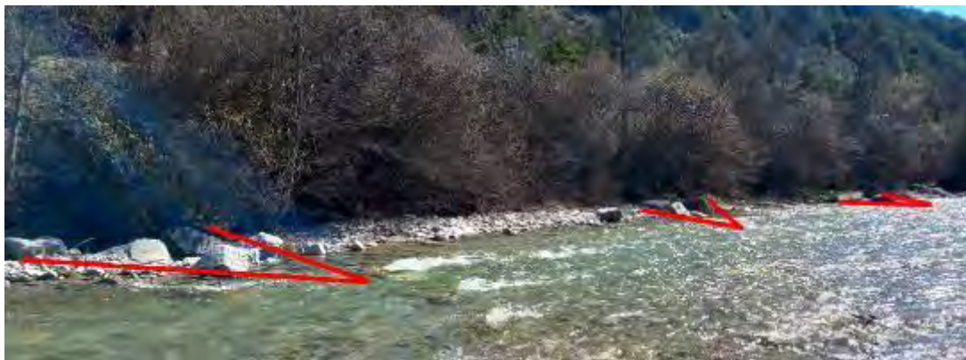
Figure 5 : Anciens épis protégeant la rive gauche dans la zone de contraction imposée par la digue Levas (AMETEN, 2023)
