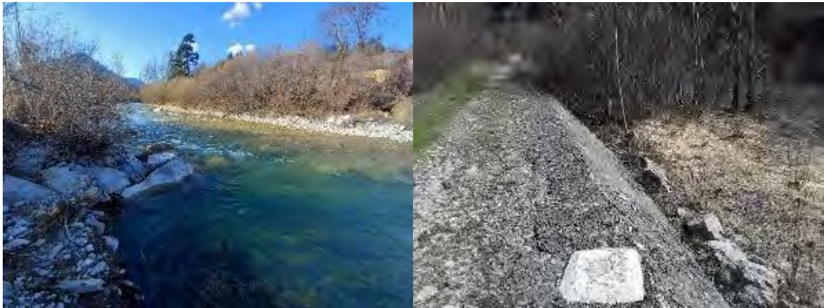
Figure 8 : Vues successives des aménagements en rive droite source du report des écoulements en RG puis de la protection de berge en RG liée à la traversée du pipeline (AMETEN, 2023)
