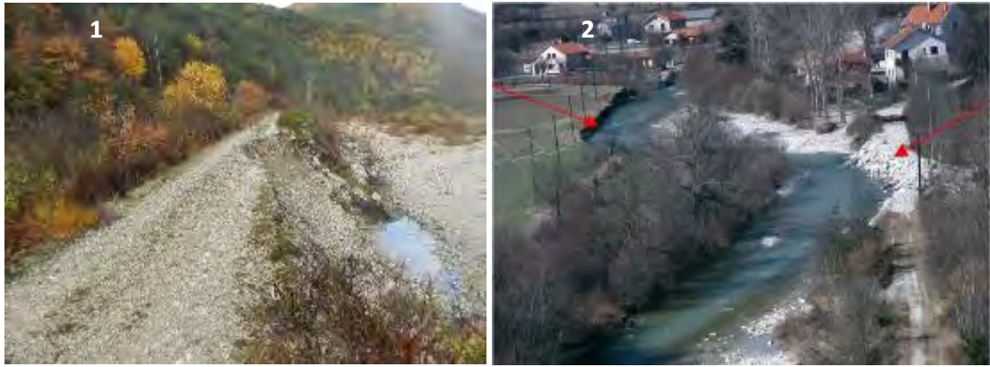
Figure 10 : 1 – Erosion de l'amont de la digue de la plaine des Levas (SMIGIBA, 2014) et 2 – Evolution morphologique du Grand Buëch en aval du pont de St-André lors de la crue de 2002 (SMIGIBA, 2002)
